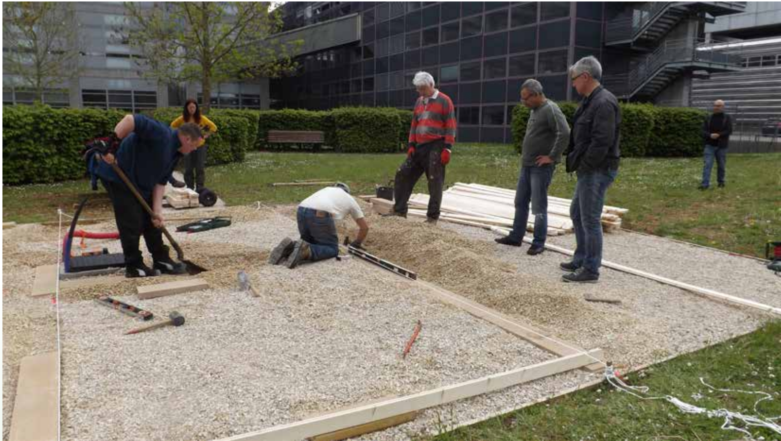
Préparation du « chantier » avant montage
